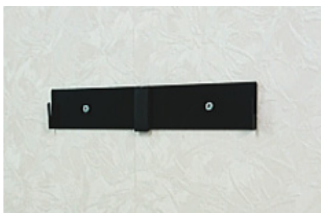
耐震壁掛金具を壁面に固定
